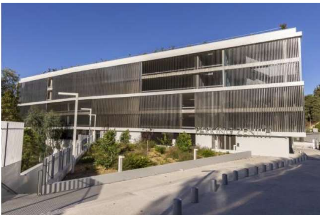
Nouveau parking Zenith - Préfecture / Toulon
